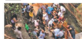
Colapso en Cuernavaca Dos funcionarios sabían que el puente no era seguro DAVID MONROY - PAG. 18
