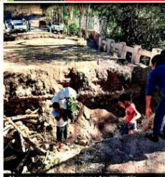
Las carreteras que comunican a Aguajilla están bloqueadas con barriles hechos por el crimen para frenar el ingreso de rivales a la zona.
