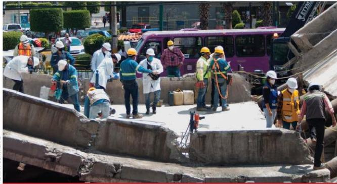
Concluyeron por parte de los peritos noruegos los trabajos de levantamiento de evidencia del lugar donde colapsó una estructura de la Línea 12 del Sistema de Transporte Colectivo (STC) Metro a la altura de la estación Los Olivos. También se trabajó en el apuntalamiento en las dos secciones donde se suscitó el desplome, con el objetivo de evitar un deslizamiento y permitir la toma de muestras de concreto.
