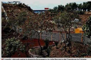
El predio, ubicado entre la Avenida Primavera y la calle Barranca del Zapote en la Colonia Lomas de la Estancia en Ixtapalapa, tiene una extensión de 26 mil metros cuadrados.
