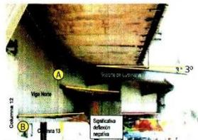
A La Viga T-6, una de las vigas se desplomó, muestra un pandeo.
