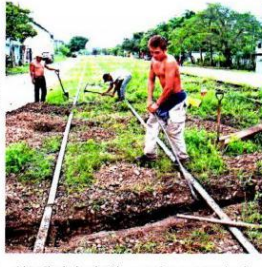
López Obrador ha advertido en diversas ocasiones que quiere dejar el Tren Maya funcionando a finales de 2023 y ha expuesto repeticiones de las empresas encargadas de su construcción para acelerar las obras.
